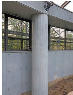
図13 作業後 浮造りを施した柱。
