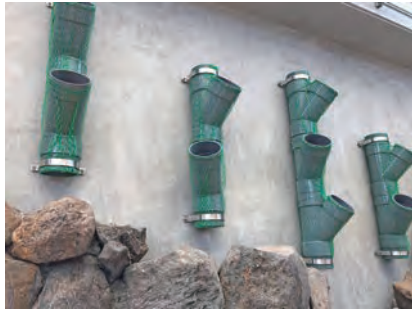
図45 整備中 塩ビ管を取り付けた壁。
