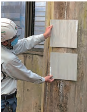
図11 コンクリートの壁 浮造りの色合わせ。
