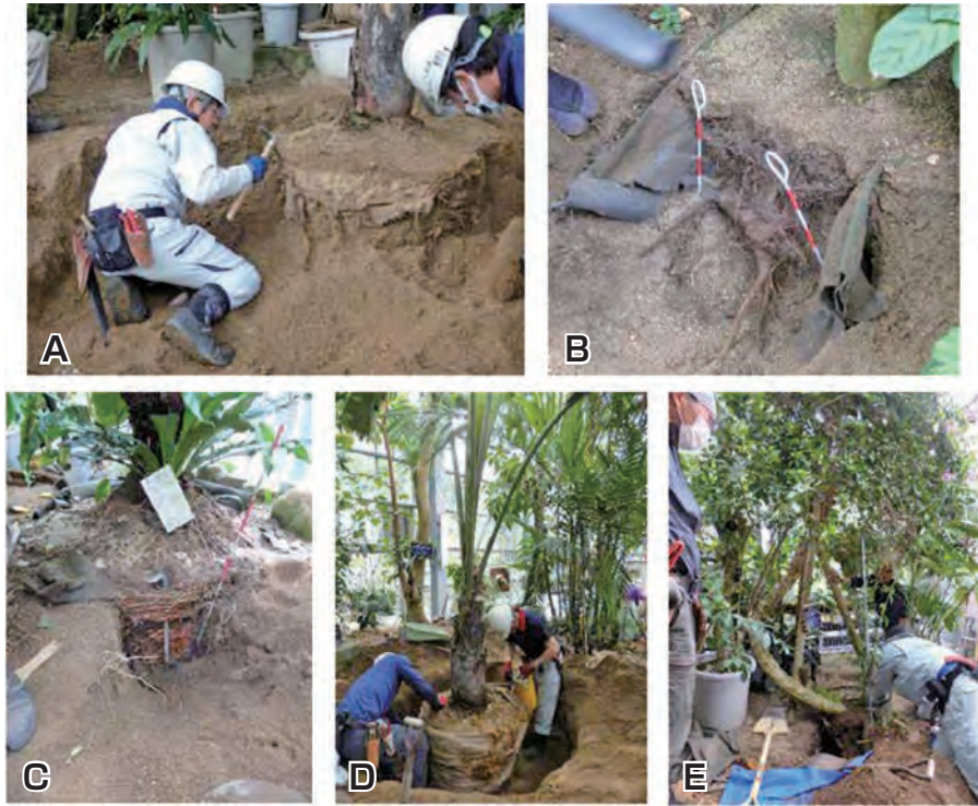
図8 根回し A：根回し方法確定のための確認状況。B：遮根シートから突き出たムユウジュの根。C：シートの内側で巻いているオガサワラビロウの根。D：オオミヤシの根巻状況。E：イカダカズラの根と葉の状況。
