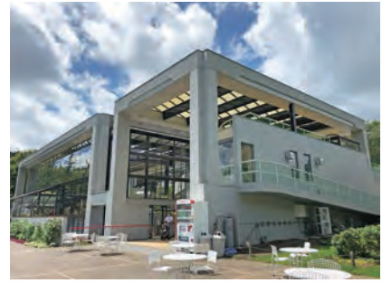
図17 再整備後の外観 明るくなった温室。
