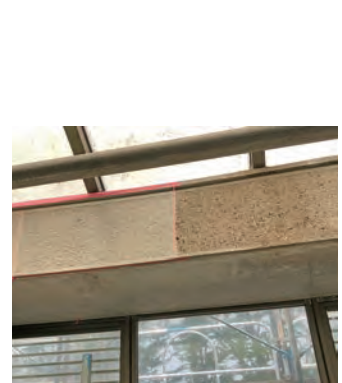
図14 その他の壁 塗装前後の明るさの違い。
